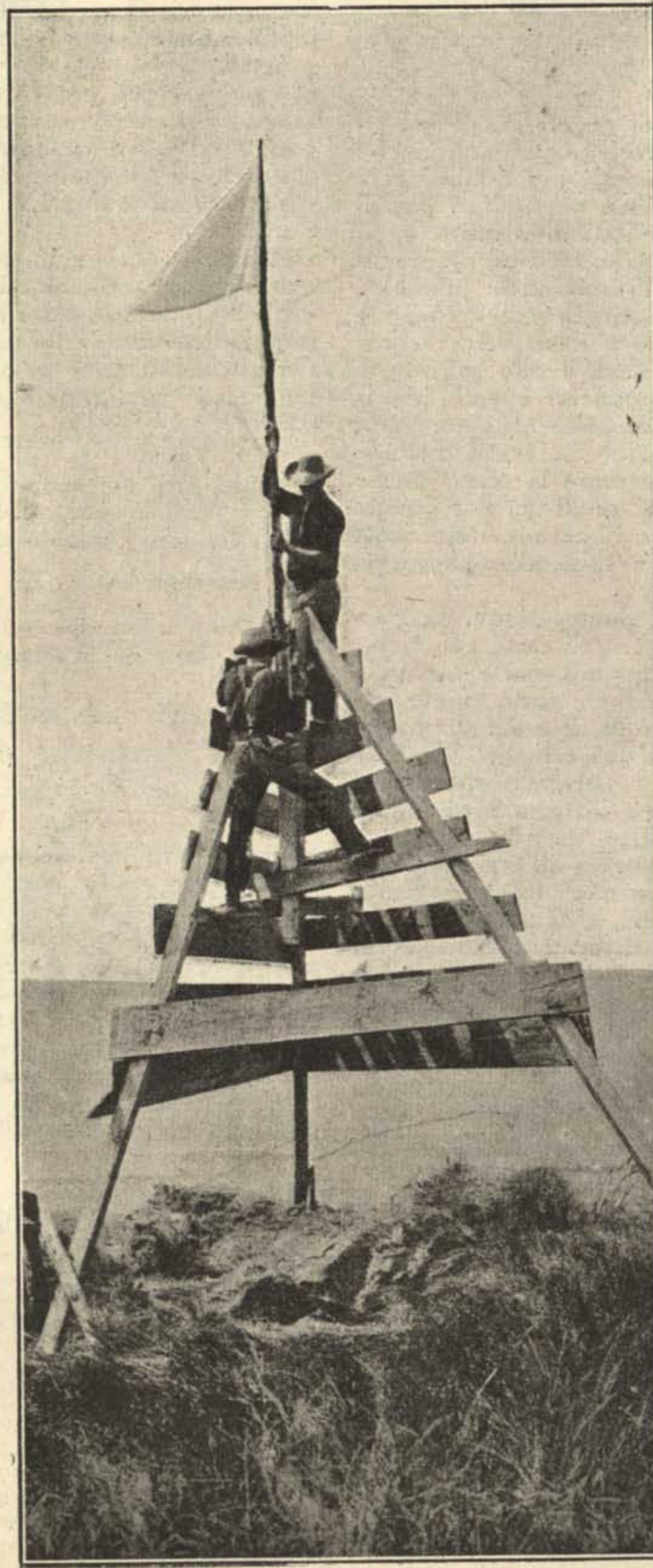
Fig. 1. — Un segnale trigonometrico provvisorio, per la triangolazione del terreno, rappresentante uno dei vertici di un triangolo.
